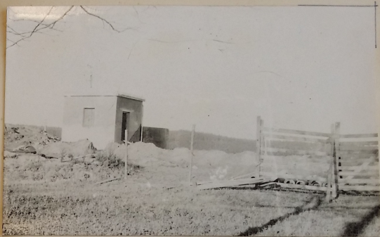
Pohled na vedlejší nádrže zhruba dostavěnou na podzim 1963.
