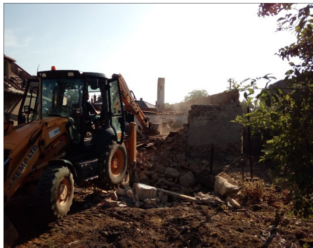
Demolice domu č.p.50
